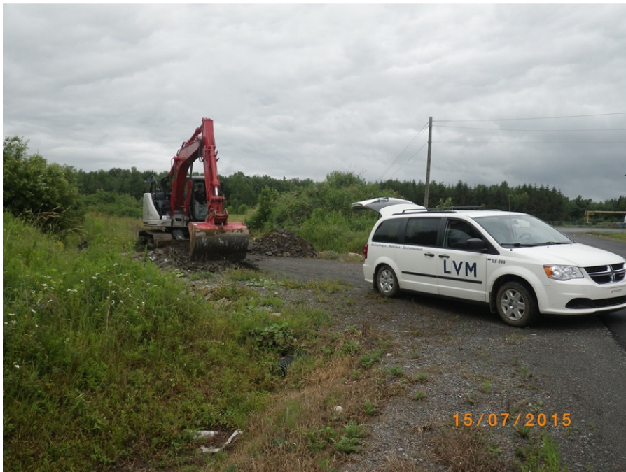
Photo 4 : Emplacement de la tranchée TE27-3
