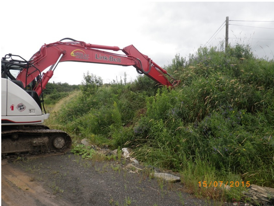
Photo 2 : Emplacement de la tranchée TE27-2
