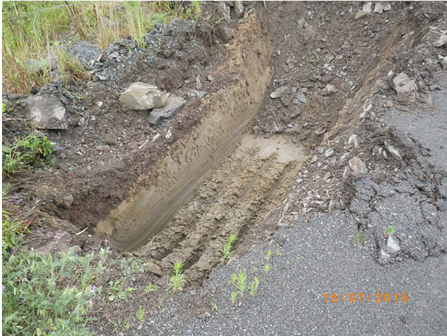
Photo 1 : Vue de la tranchée TE27-1
